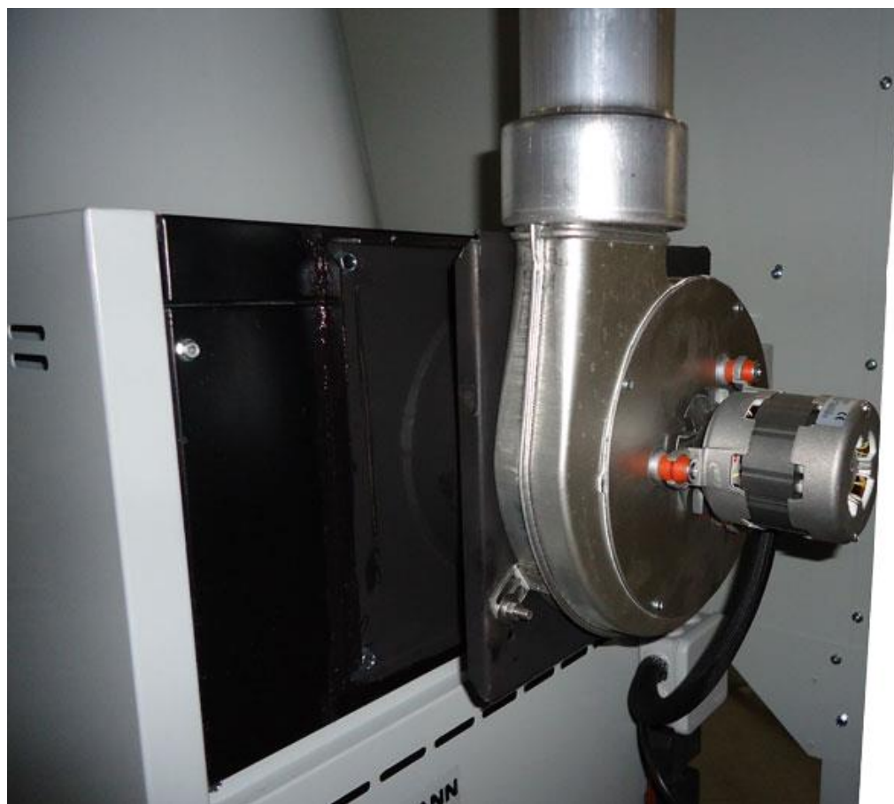
BIO MANN ventilátor spalovacího vzduchu / kouře
