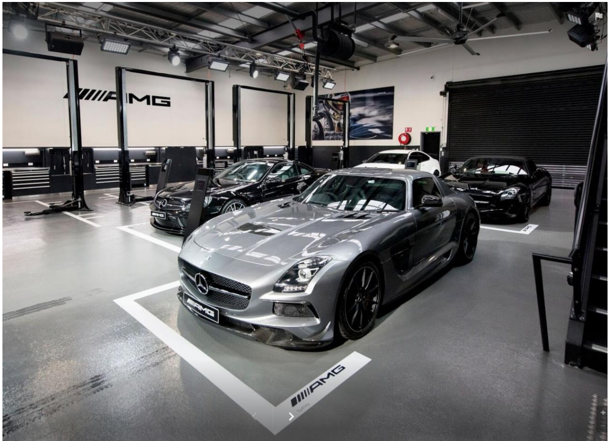
HVLS ventilátor instalován v autosalon
